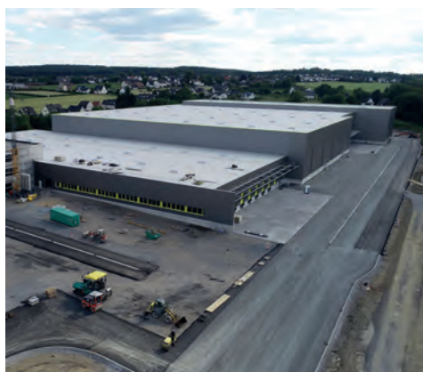
Neubau Hauptsitz TRIO Leuchten | Arnsberg
