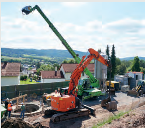
Schachteufarbeiten | Stockheim (Oberfranken)
