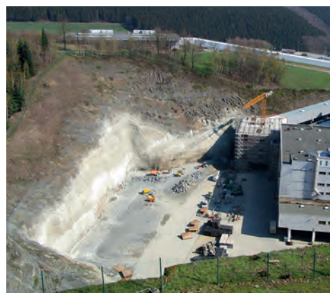
Felsabtrag u. Hangsicherung Veltins | Meschede
