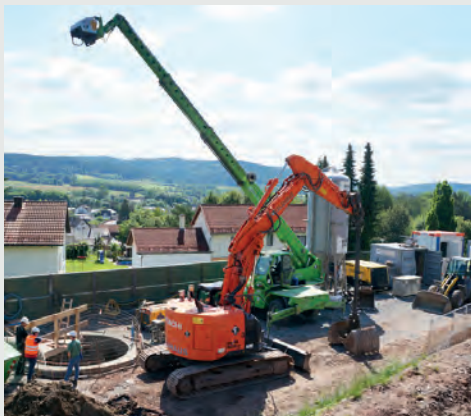
Schachteufarbeiten | Stockheim (Oberfranken)
