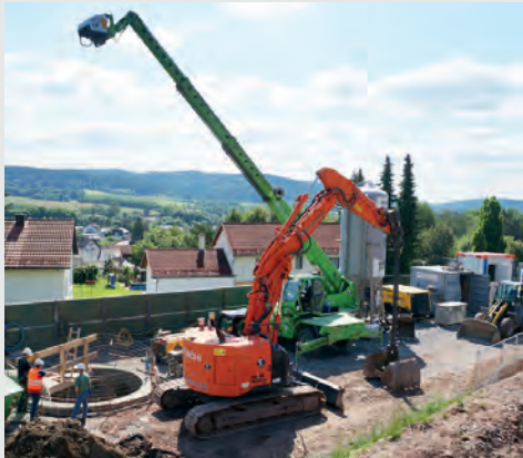
Schachteufarbeiten | Stockheim (Oberfranken)
