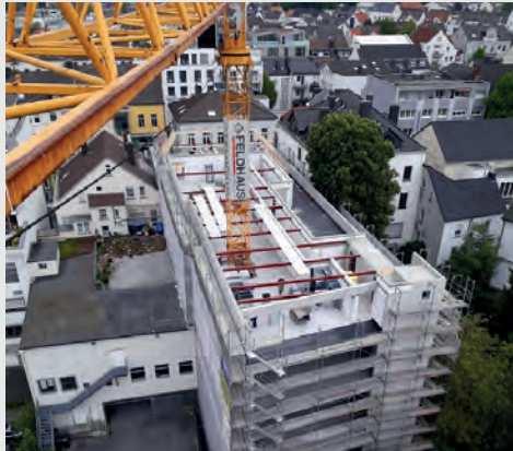
Neubau Modehaus Kress | Arnshausen-Neheim
