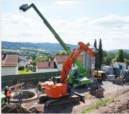
Schachtteufarbeiten | Stockheim (Oberfranken)
