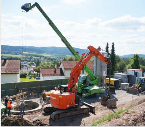
Schachtteufarbeiten | Stockheim (Oberfranken)
