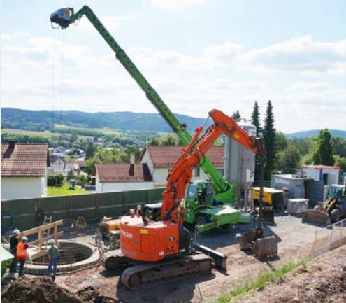
Schachtteufarbeiten | Stockheim (Oberfranken)
