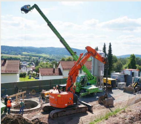
Schachteufarbeiten | Stockheim (Oberfranken)
