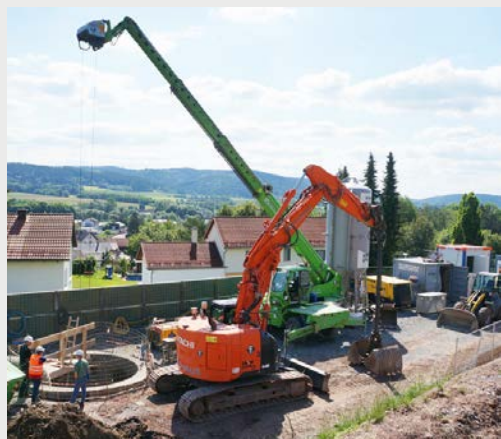
Schachtteufarbeiten | Stockheim (Oberfranken)
