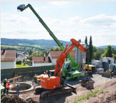
Schachtteufarbeiten | Stockheim (Oberfranken)
